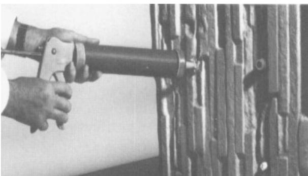
22. Wir empfehlen Ihnen dagegen unsere Methode: Das Loch der Distanzröhre (Abstandsrohre) mit kleinen Polystyrolzapfen stopfen, danach auf eine Tiefe von ca. 2 cm mit grauem Fugenkitt mit der Presspistole ausfüllen und der Struktur mit nassem Finger (Gummihandschuhe) oder kleinem Spachtel anpassen.
